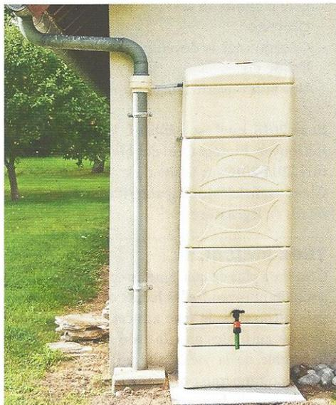
Pourquoi gaspiller de l'eau potable qui coûte cher pour des activités qui ne le nécessitent pas? L'eau de pluie, outre le fait qu'elle soit gratuite, ne contient ni calcaire ni chlore. Pour des usages comme l'arrosage et le nettoyage, ou même les chasses d'eau et le lave-linge, il n'y a pas mieux!
